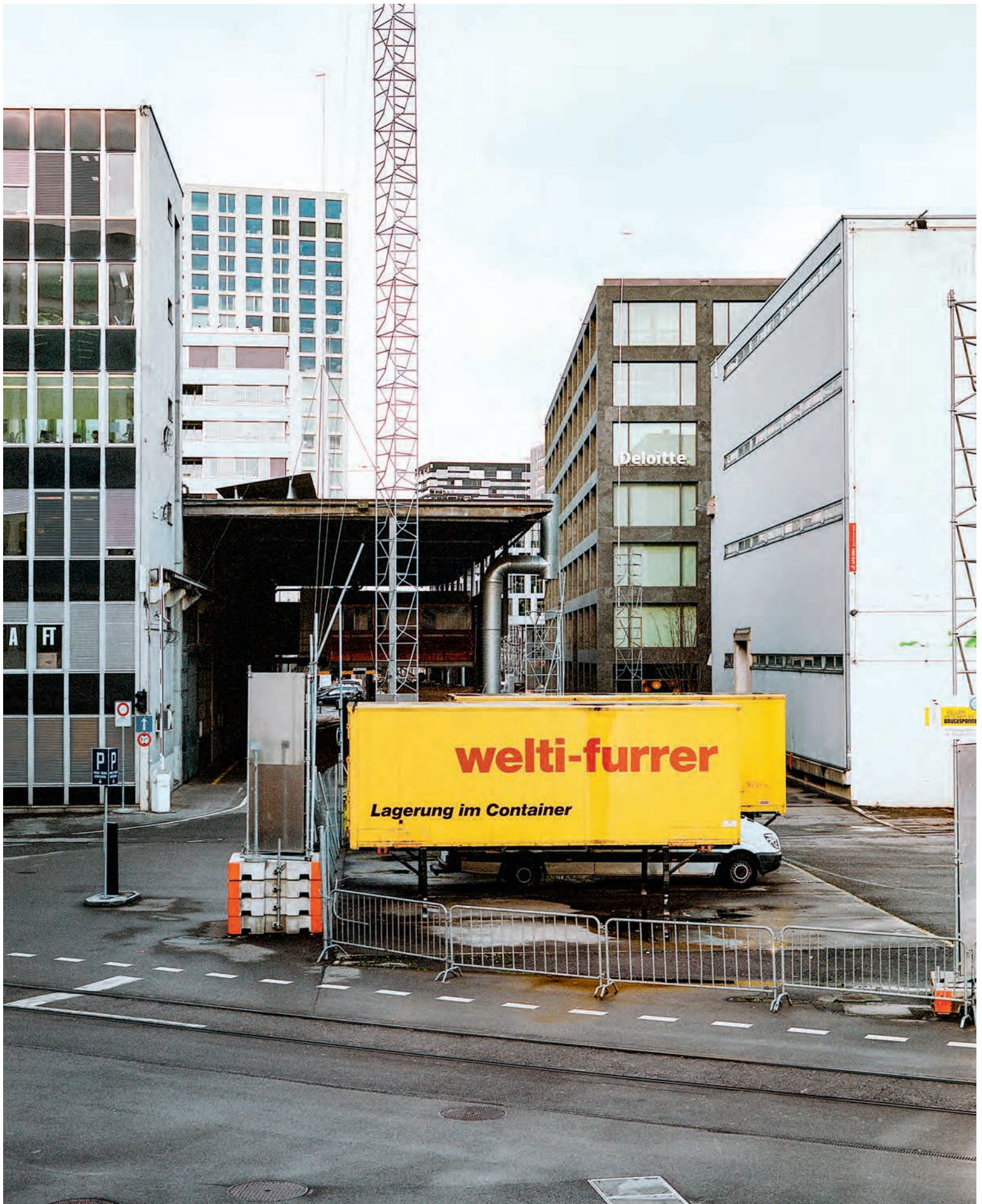
Wie weiter mit dem Maag- und dem Wolti-Furrer-Areal? Noch ist die historische Vergangenheit sichtbar, bald könnte sie verschwunden sein.
